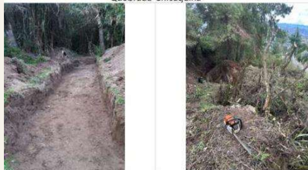
Quebrada Huayrapata Alto Tramo 1
