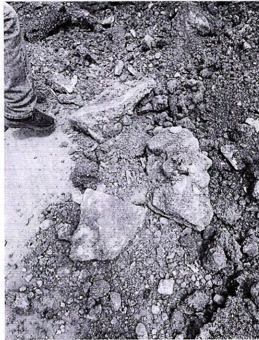
Escombros de baldosa con hormigón en rellenos
