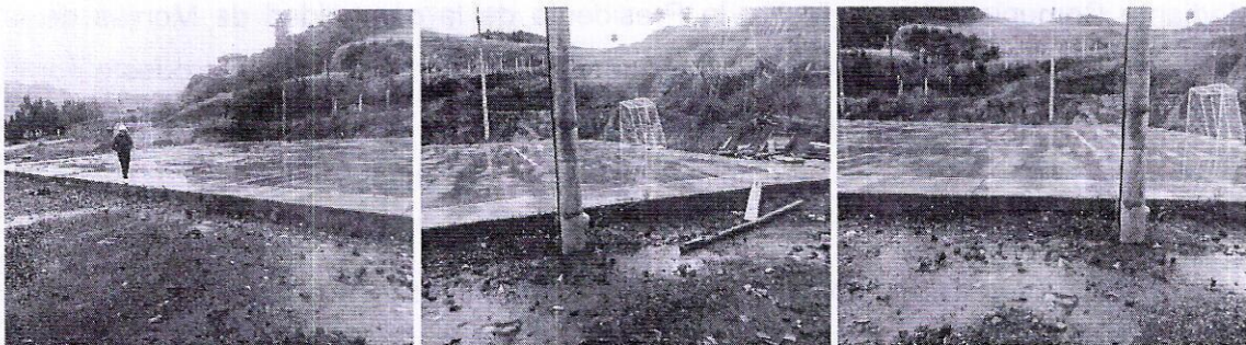
Fotos tomadas en la obra por equipo de Contraloría.
