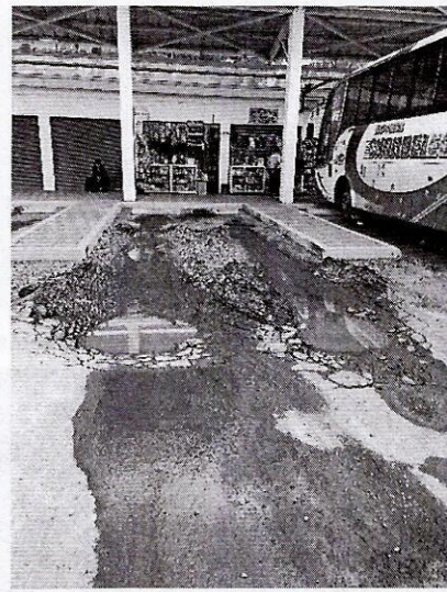
Estacionamiento 3 zona de embarque
