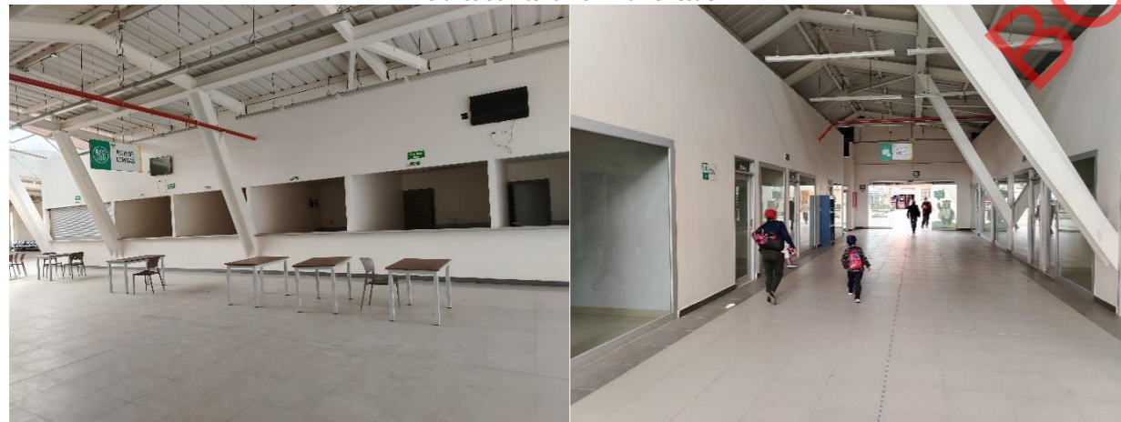
Gráfico 56 Interior Terminal Terrestre
